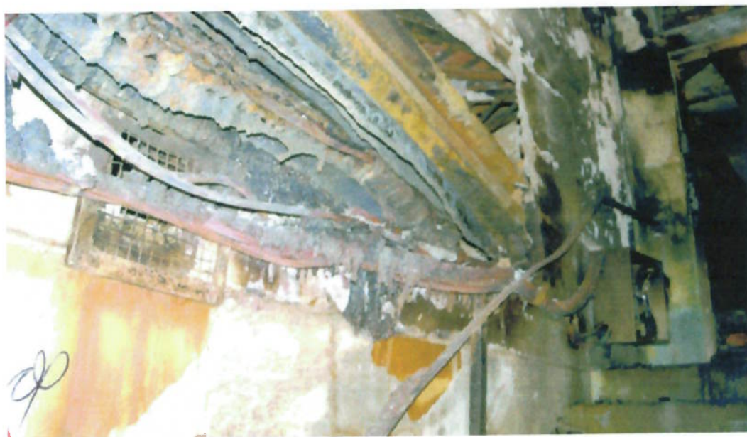
Figura 4 – Detalhes dos Eletrodutos com Sinais de Curto e Arcos Fusão (Laudo Técnico)
