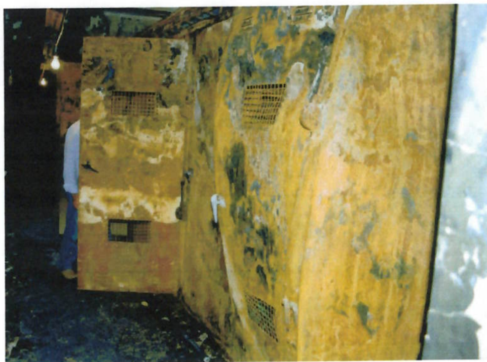
Figura 8 – Portas Estufadas na Cabine de Barramentos
